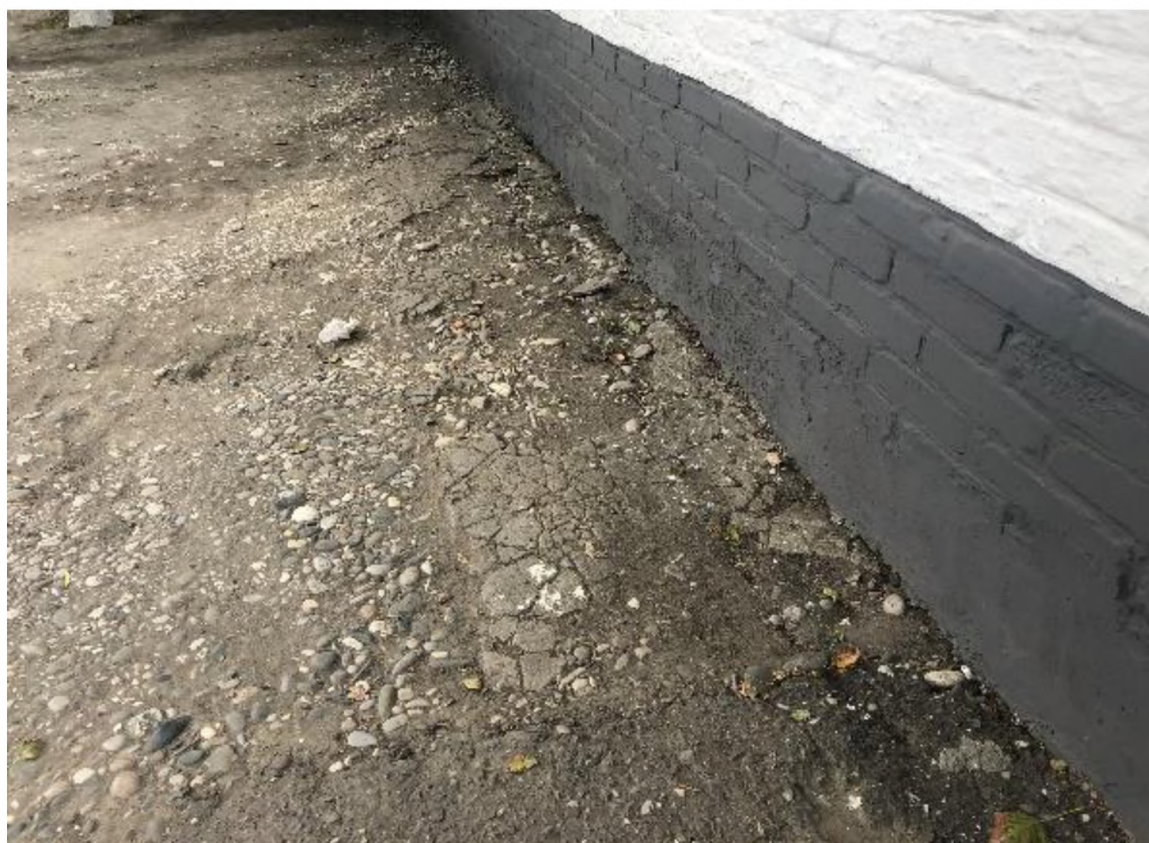
Фото №11. Состояние фундаментных-цокольных стен, отсутствие отмостки.
