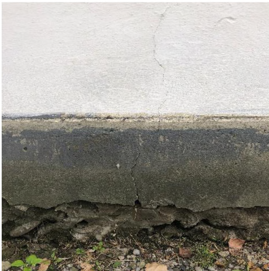
Фото №11. Состояние фундаментных-цокольных стен, отсутствие отмостки.
