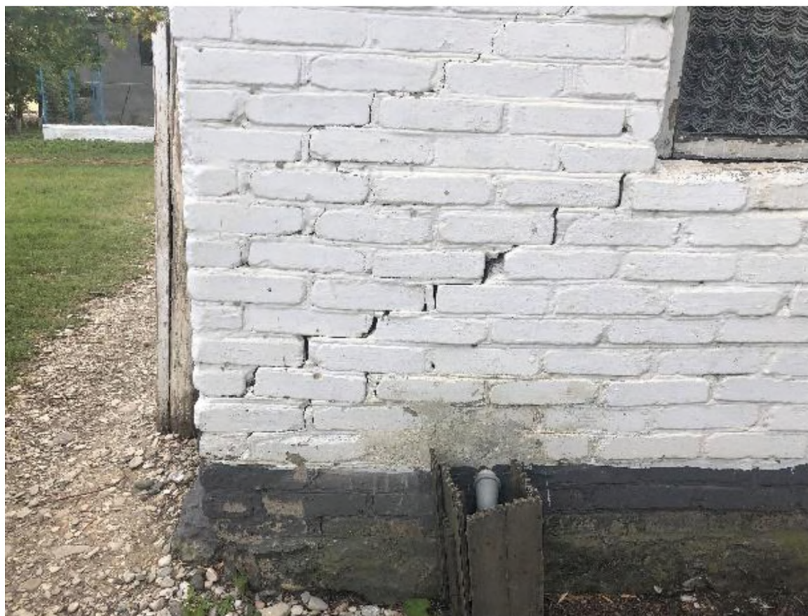
Фото №14. Трещина по стене
